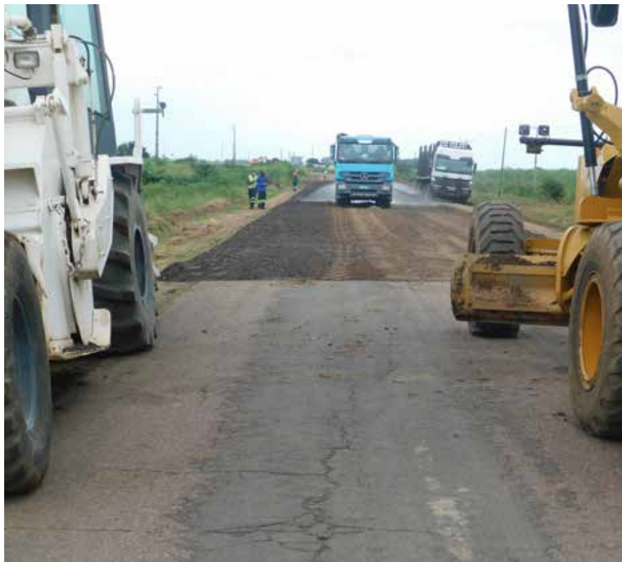
Obras de manutenção de estradas
