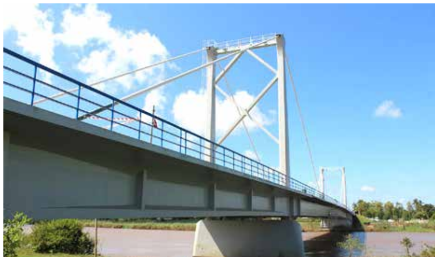
Ponte sobre rio Limpopo
