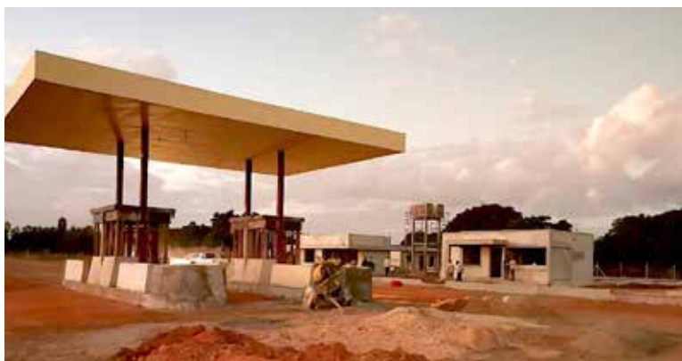
Obras de portagem de Nampula
