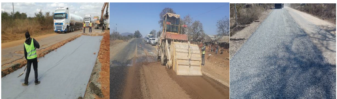
Figura 4: Estado actual da Estrada
